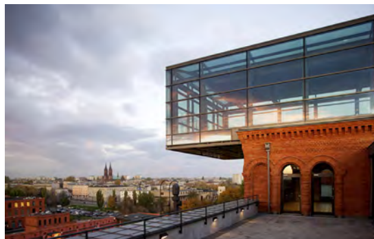
Constructie afleesbaar bij nieuwbouw
