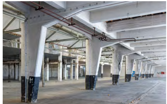
Kwaliteit: zichtbaar houden constructie
